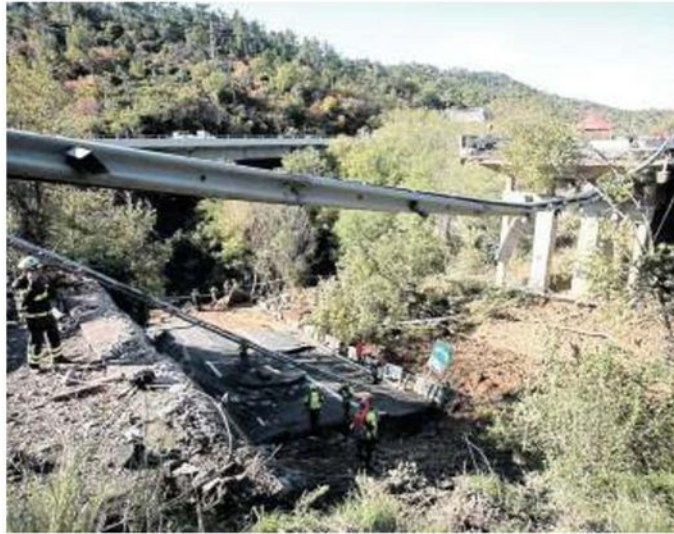
Il viadotto crollato domenica sull'autostrada A6
