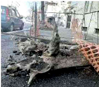
Il tronco rimasto a terra dopo il crollo in via Imeria
